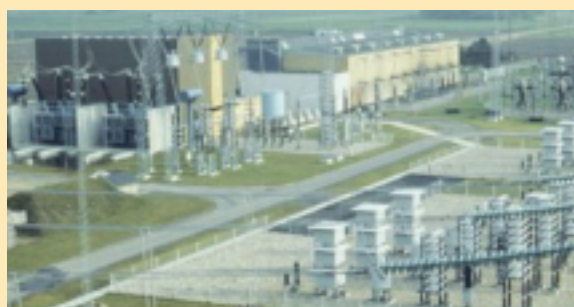
Aspecto externo de estación de conversión LCC (izquierda) en Dinamarca (Kont Skan, 2001, 300 MW) e interior de uno de los convertidores (derecha), donde se aprecia el montaje vertical de los tiristores.
