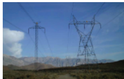
■ Comparación de torres HVAC (800 kV, 2000 MW) y HVDC (500 kV, 3000 MW).
